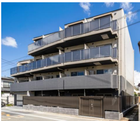
中野弥生町マンション 2023年7月竣工
