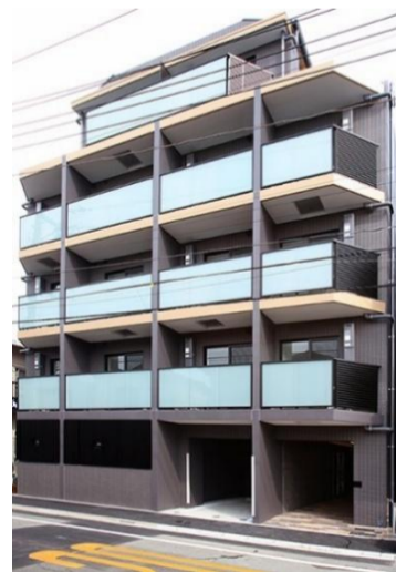
高島平マンション 2021年3月竣工
