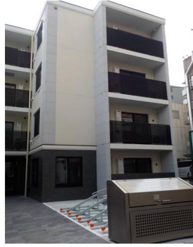
西新宿マンション 2024年8月竣工
