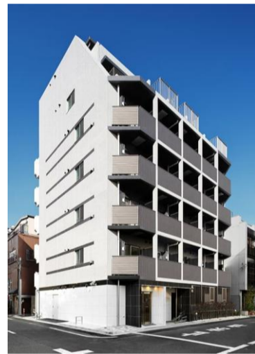
向島マンション 2018年3月竣工
