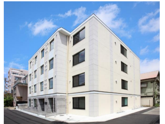
上原マンション 2022年7月竣工
