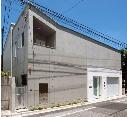
西落合A邸 2014年5月竣工
