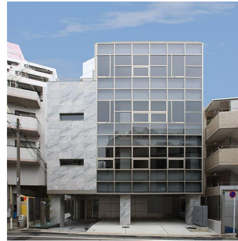
千葉金属ビル 2015年12月竣工
