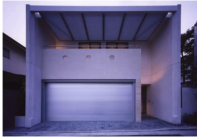
渋谷区Y邸 2001年3月竣工
