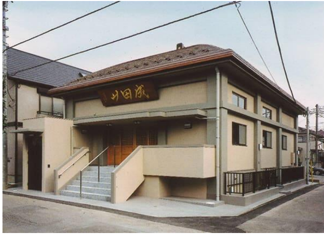
成田山恵勝寺 1999年11月竣工
