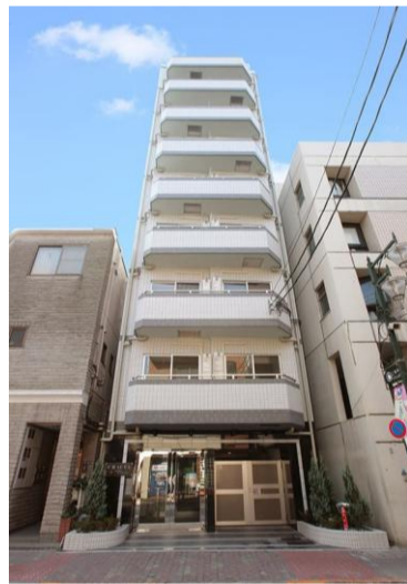
西蒲田マンション 2011年10月竣工
