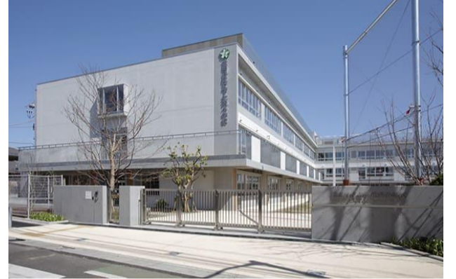
下北沢小学校 2018年3月竣工
