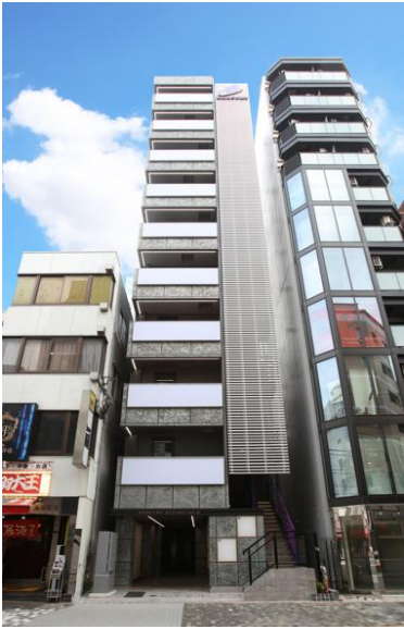
錦糸町ビル 2024年8月竣工
