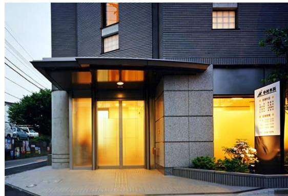
N外科 2000年12月竣工
