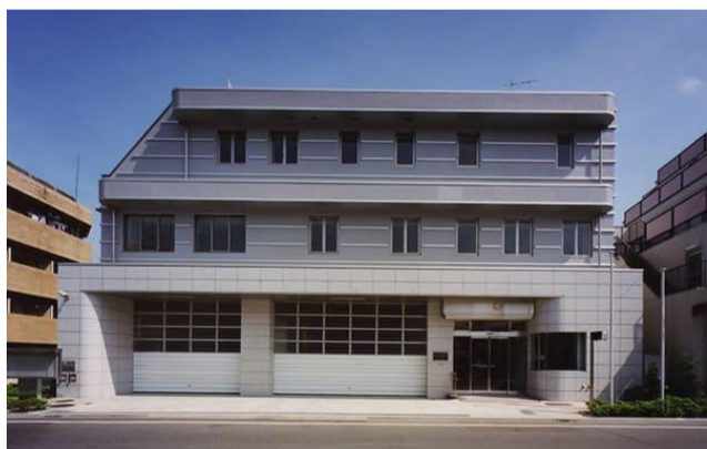
成城消防署烏山出張所 1998年4月竣工
