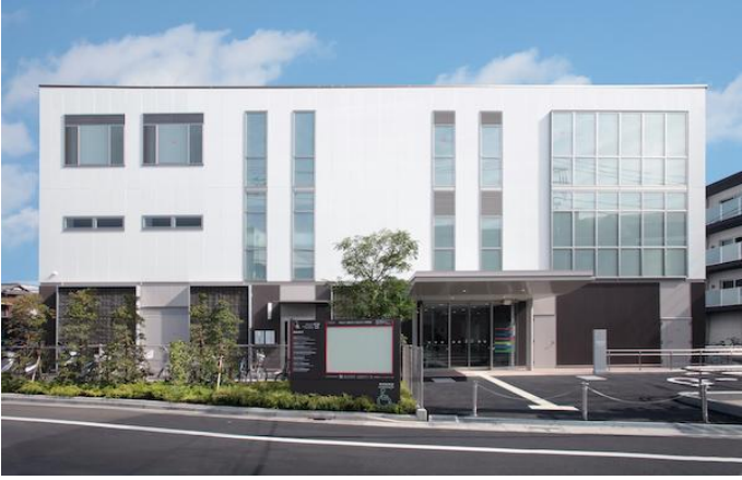
若林複合施設 2020年10月竣工
