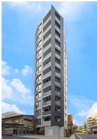
元赤坂マンション 2024年12月竣工
