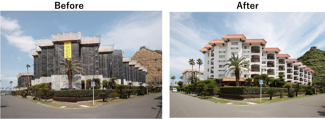
逗子マリーナ6号棟建物大規模修繕工事 2013年7月竣工
