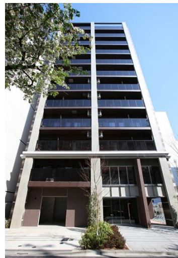
東日暮里マンション 2021年3月竣工
