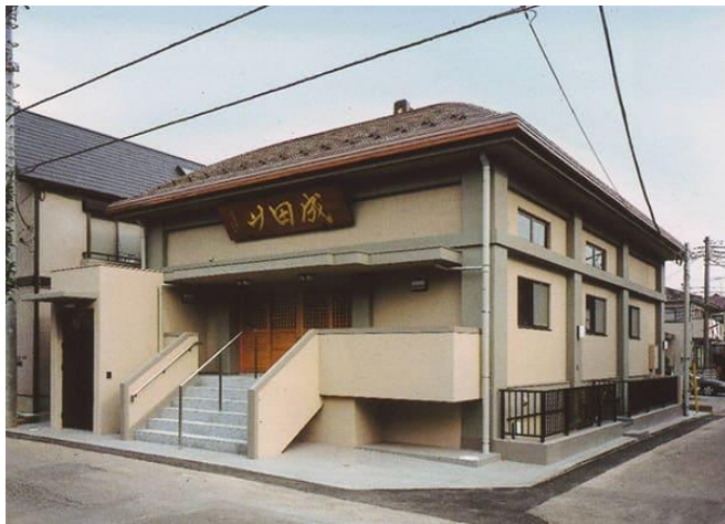
成田山恵勝寺 1999年11月竣工
