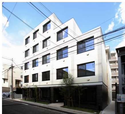
中野富士見町マンション 2023年9月竣工
