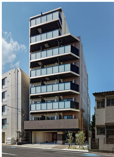
新蒲田マンション 2022年6月竣工
