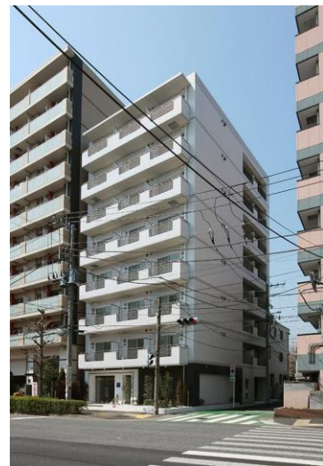
吉野町マンション 2014年3月竣工
