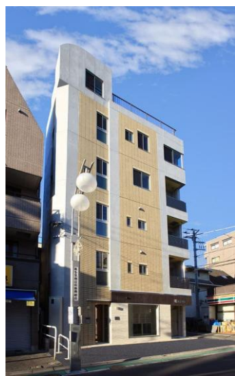
喜多見マンション 2016年3月竣工
