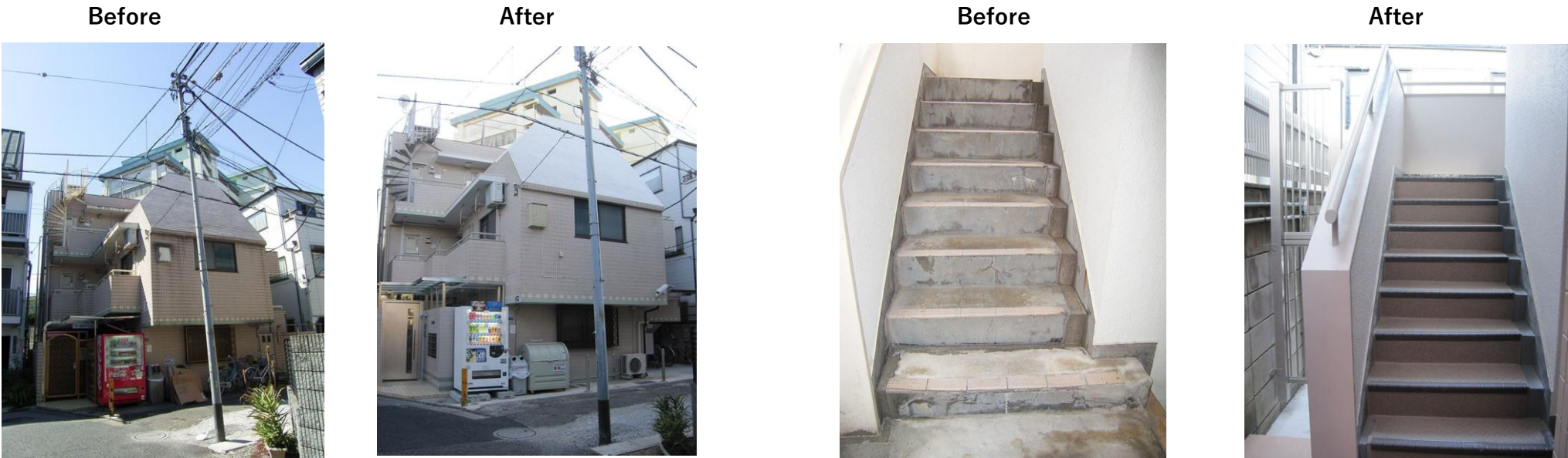
ローズガーデン戸山大規模修繕工事 2011年1月竣工
