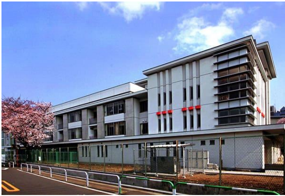
駒沢小学校 2008年1月竣工
