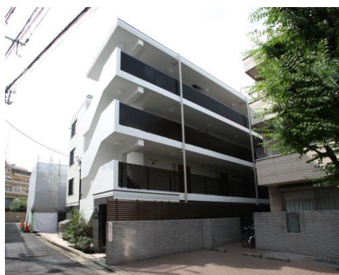
三軒茶屋Ⅱマンション 2023年9月竣工
