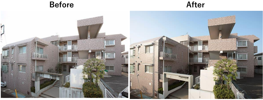
ヴィラ経堂大規模修繕工事 2013年3月竣工
