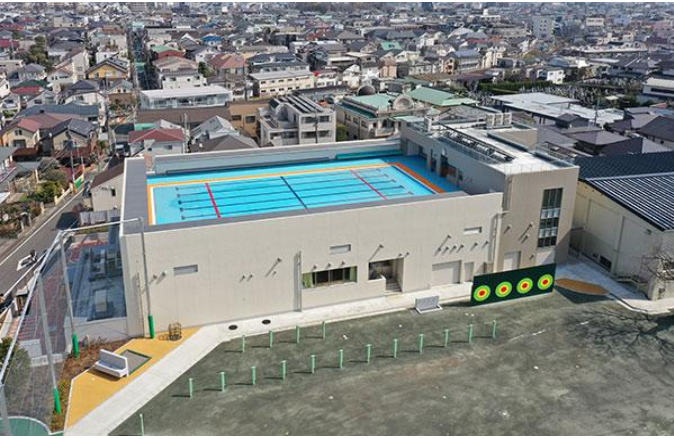
松原複合施設 2022年3月竣工
