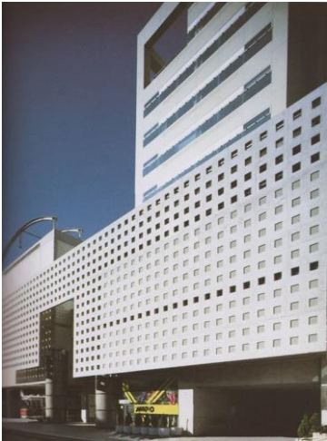
北沢タウンホール 1990年6月竣工
