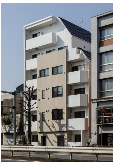
上野毛マンション 2016年3月竣工
